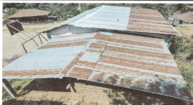
Foto1: Techo por fuera
