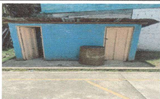
Foto 5: Puertas y techo de sanitario
